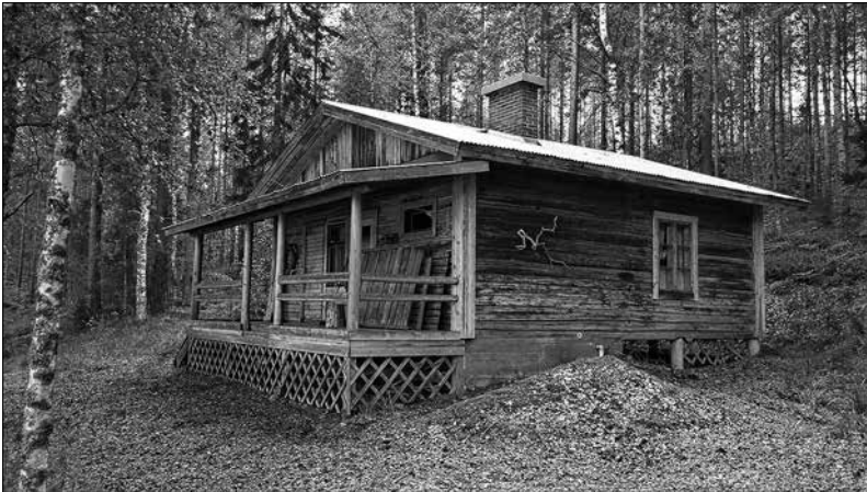
Kuva 104. Tainaveden rannassa oleva vanha Yrjölän tilalta vuonna 1975 siirretty hirsirakennus, joka oli Yrjölän tilan (2:2) ensimmäinen asuinrakennus. Perimätiedon mukaan tämä rakennus on ollut ennen isojakoa Pekkolan tilan savutupa Mäntyharjun kirkonkylässä Pekkolanlammen rannalla. Se siirrettiin isojaossa 1848 Varpaseen ensin Pällin tilalle (2:3) ja sieltä 1900-luvun alussa Yrjölän tilalle. Toinen savutupa Pekkolanlammen rannalta lienee siirretty Tainaan isojaossa muodostetulle Pekkolan tilalle (2:1), jota alkoivat isännöimään Christer Pekkolan (s. 1779) poika Adam Pekkola (1816–1901) ja leski Anna (s. 1792). (Kuva Heikki Torniainen 2023)
