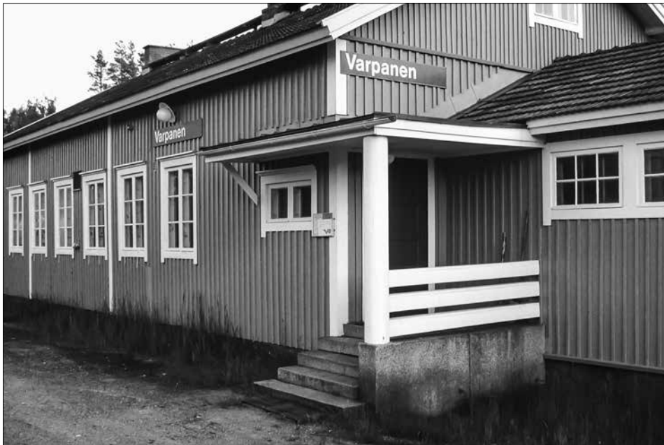
Kuva 35. Varpasen asema vuonna 1990. (Kuva Heikki Torniainen)
