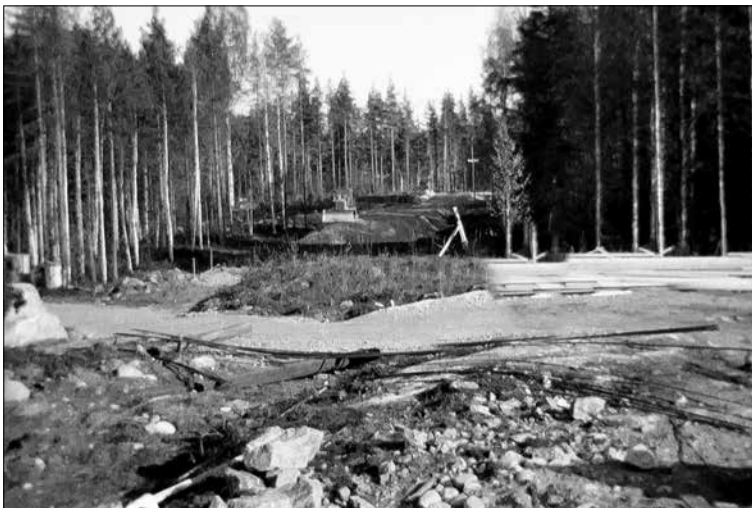
Kuva 20. Piirantien rakennustyömaa uuden radanyhteyksillan itäpuolella vuonna 1980. (Kuva Heikki Torniainen)
