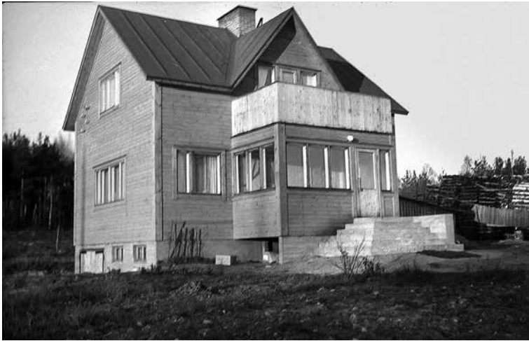
Kuva 100. Toivo Montosen 1950-luvulla rakennuttama talo Tenholan tilalla, Petäjämäentie 21.
