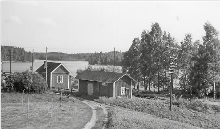
Kuva 8. Vanha pysäkkirakennus vasemmalla, takana rautatie ja Iso-Varpanen.
